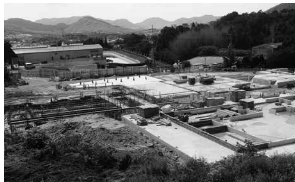
工事が始まった観光交流施設 （筆の里工房周辺整備事業）
