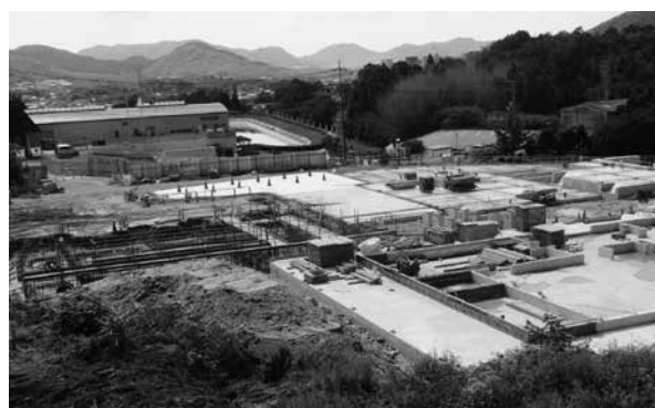
工事が始まった観光交流施設 (筆の里工房周辺整備事業)
