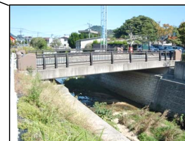
庁舎橋 L=14.5m(PC橋) 2001年架設
