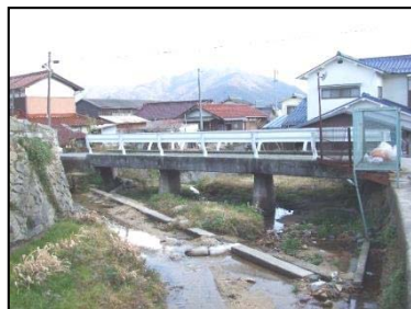
慶神橋 L=13.3m(RC橋) 1960年架設
