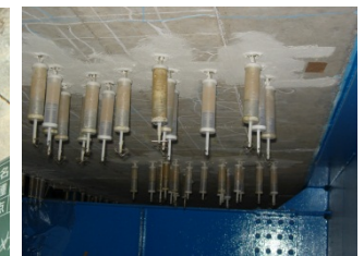
ひびわれ注入工
