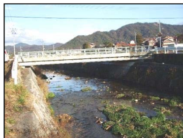
川角大橋 L=18.2m(PC橋) 2005年架設
