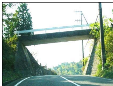
菊ヶ原橋 L=12.5m(PC橋) 1980年架設
