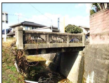
熊野橋 L=7.0m(RC橋) 1960年架設
