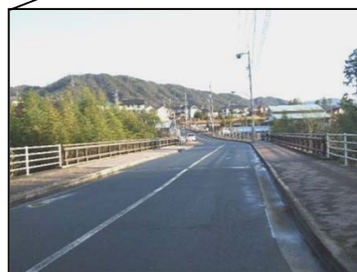
さくらの橋 L=36.0m(PC橋) 1996年架設
