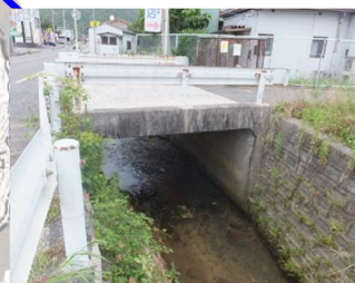
稲荷橋 L=4.1m (BOX) 1975 年架設
