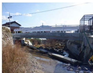
慶神橋 L=15m (鋼橋) 2020 年架設 (架替)
