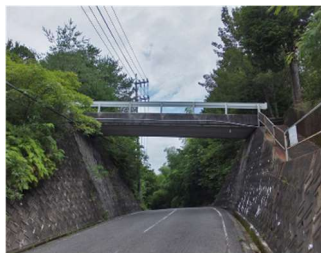
菊ヶ原橋 L=12.5m (P C 橋) 1980 年架設
