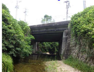
熊野押込橋 L=10.5m (R C 橋) 1967 年架設
