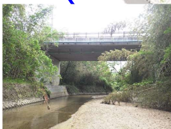
さくらの橋 L=36m (P C 橋) 1996 年架設
