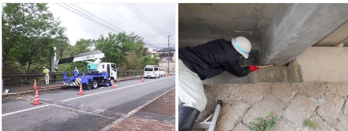
橋梁定期点検状況
