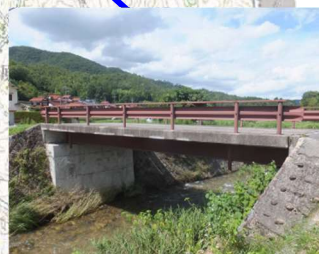
時山橋 L=10.5m (鋼橋) 1972 年架設
