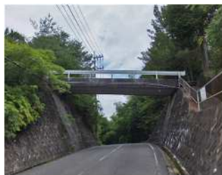
菊ヶ原橋 L=12.5m (P C 橋) 1980 年架設
