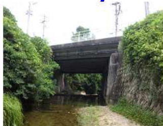
熊野押込橋 L=10.5m (RC 橋) 1967 年架設
