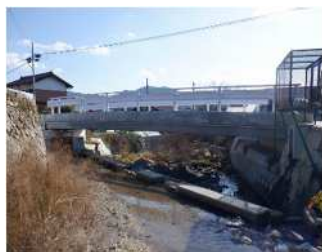
慶神橋 L=15m (鋼橋) 2020 年架設 (架替)
