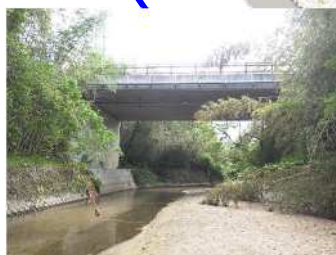
さくらの橋 L=36m (P C 橋) 1996 年架設
