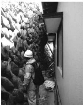
全体の被害状況を把握しながら、宅地の平面図、被害箇所の断面図を調査票に記載していきます。
