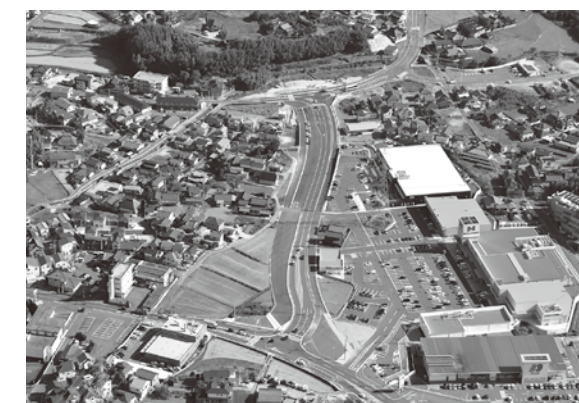
▲県道矢野安浦線バイパスの供用開始区間
