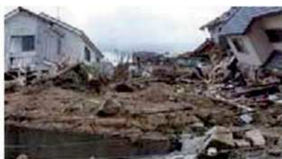
大原ハイツの土石流 出典：熊野町平成 30 年 7 月豪雨被災誌
