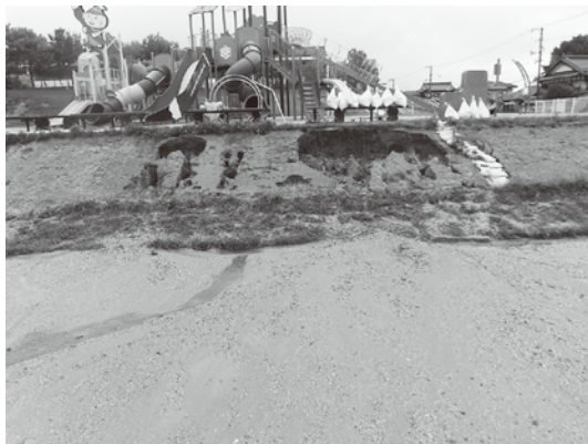
▲修繕予定の西防災交流センター駐車場のり面
