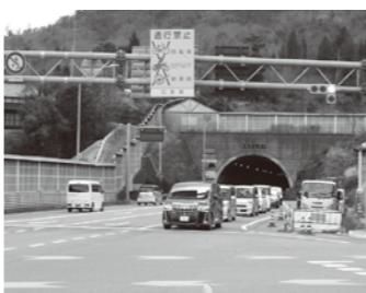
▲広島熊野トンネル
