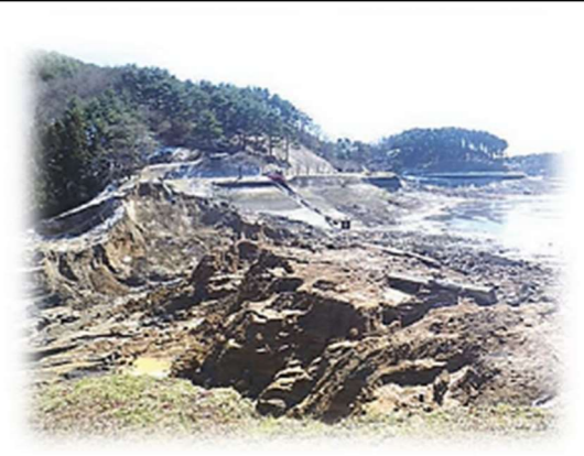
平成23年3月の東日本大震災により決壊(福島県)
