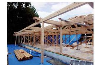
尺モジュールを用いた木造建築の事例
