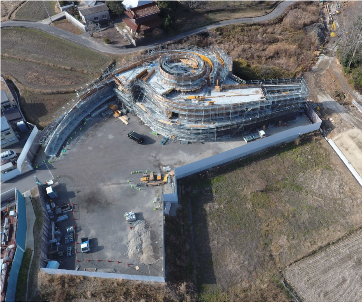
2021 年 1 月初旬 屋根までの躯体打設が完了し、年を越す
