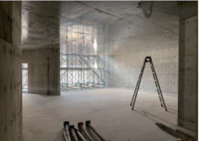
内部の型枠が外され躯体が現れてきました
