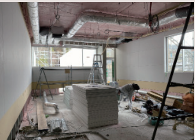
断熱材を吹き付け、ボード材が設置されました
