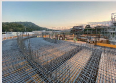
形態にあわせた鉄筋が施工されていきました
