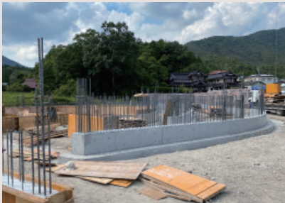
基礎の型枠が外され、形態が見え始めました
