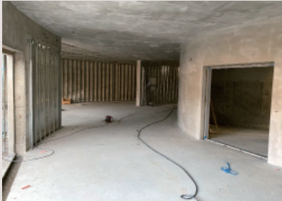
躯体補修や乾式壁の下地が施工されました
