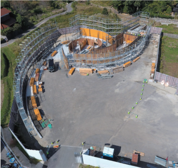
2020 年 10 月中旬 1 階壁の鉄筋・型枠工事が進む
