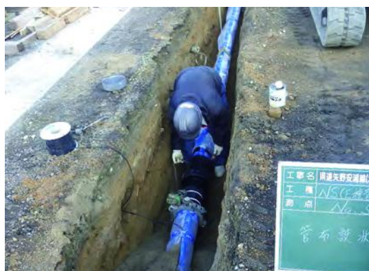
水道管の設置(上水道)
