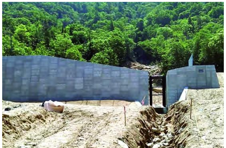
平成30年7月豪雨 大原ハイツ 復旧後
