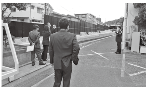
▲ 「熊野第三小学校擁壁 ようへき 改修工事」が完了した現場
