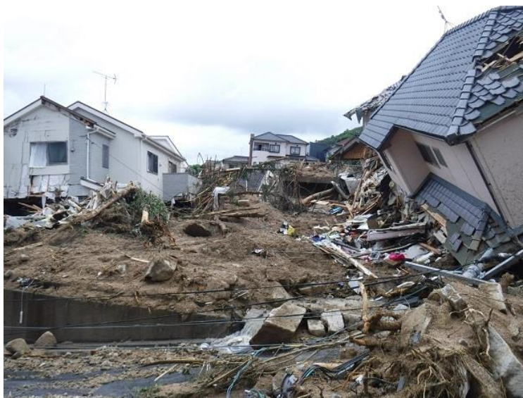
大原ハイツの土石流現場
