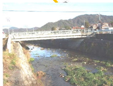
川角大橋 L=18.2m (P C橋) 2005 年架設
