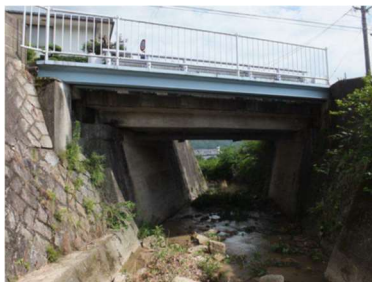
熊野橋 L=7.0m (R C橋) 1960 年架設
