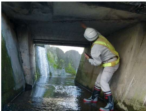
橋梁点検（上部工）
