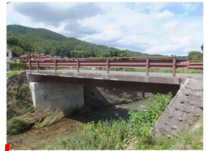
時山橋 L=10.5m (鋼橋) 1972 年架設
