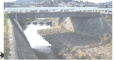
新宮南橋 L=14.2m (P C橋) 1980 年架設
