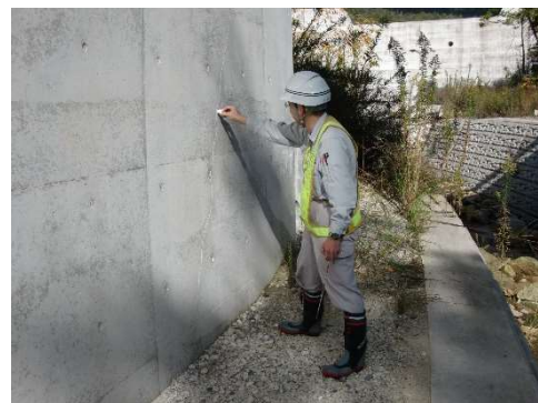
橋梁点検（下部工）
