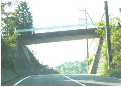
菊ヶ原橋 L=12.5m (P C橋) 1980 年架設 (跨道橋)
