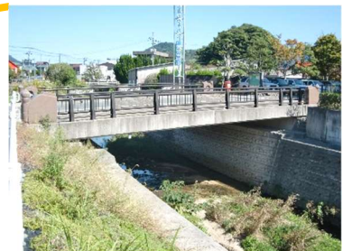
庁舎橋 L=14.5m (P C橋) 2001 年架設
