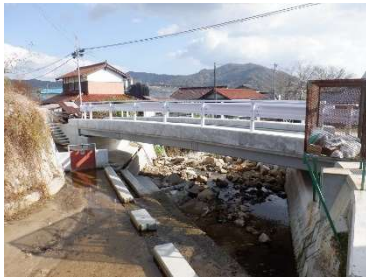
慶神橋 L=13.3m (R C橋) 2020 年架設
