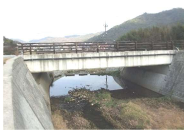
深原公園橋 L=16.2m (P C橋) 2005 年架設
