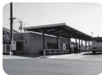
図 4.10 広島電鉄熊野営業所
