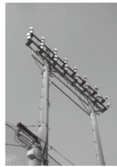
スポーツ振興くじ助成金を活用して、町民グラウンド照明設備を改修しました。 独立行政法人日本スポーツ振興センターの平成27年度スポーツ振興くじ助成金を活用して、町民グラウンドのナイター照明を改修しました。 今回の改修工事により、グラウンド照明設備の約半数がLED照明となったことで、夜間でも安定した明るさの下でスポーツを楽しむことが可能となりましたので、ぜひご利用ください。
