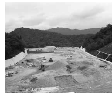
▲深原地区町有地造成地 (平成25年7月現在)
