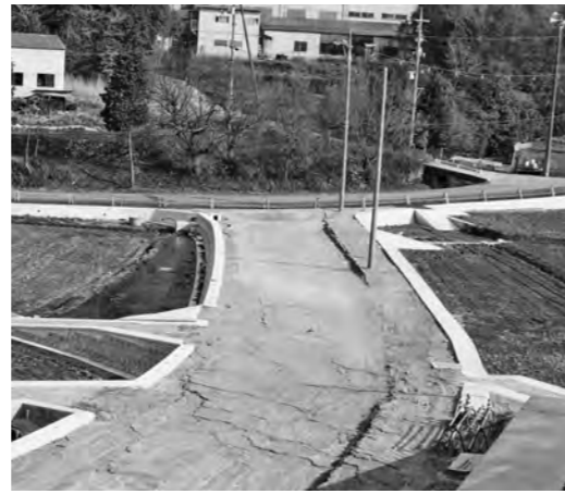
▲工事が進む町道深原公園線
