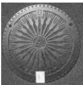
↑ マンホール蓋穴を白いシールで密閉しています。
