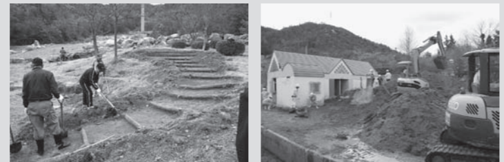
↑施設などが掘り出されている様子
