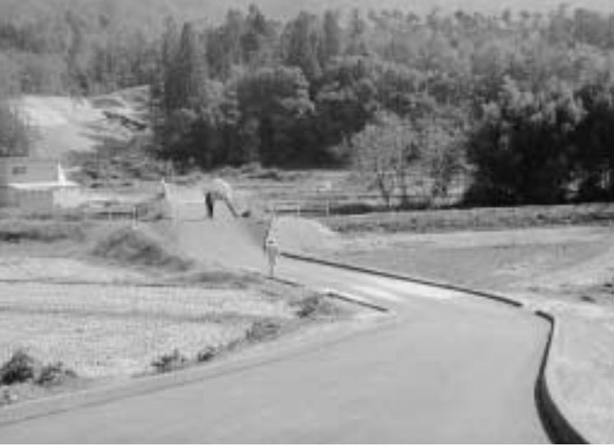
現在の状況。道路は作業用の仮設道路です。
