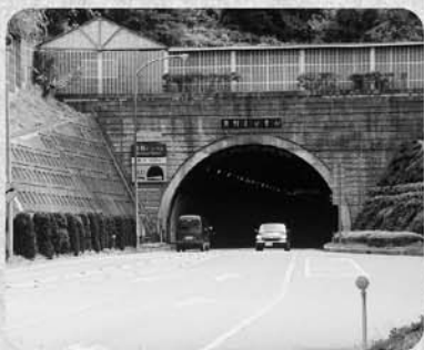
●熊野トンネル付近
