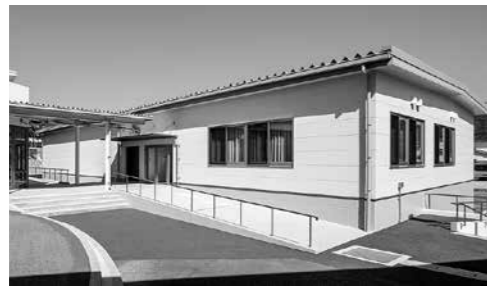
▲熊野西防災交流センター新館 (1億794万円)
