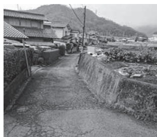
▲町道狭あい箇所
