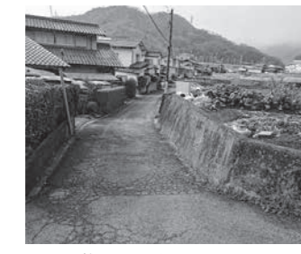
▲町道狭あい箇所
