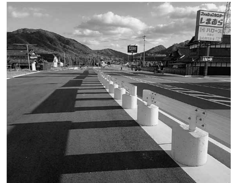
▲ 新設された県道 (ハローズ前)
