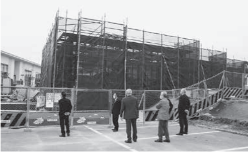
▲ 工事の進捗状況を確認
