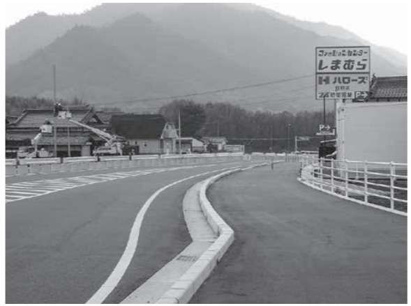
▲ 県道矢野安浦線バイパス
