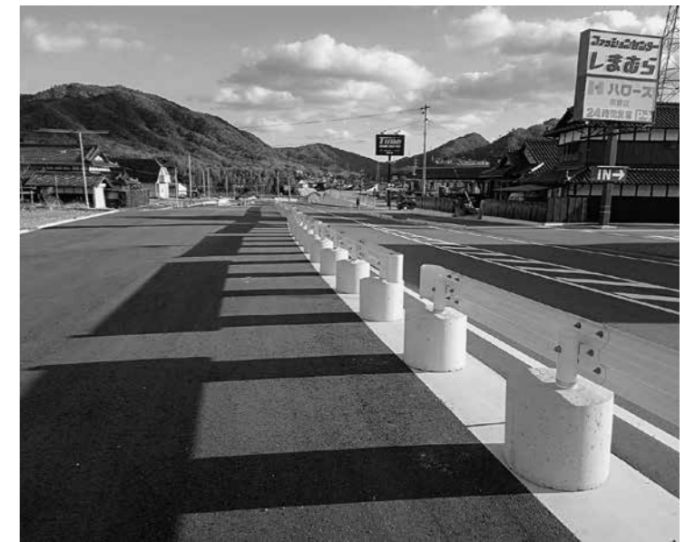
▲新設された県道（ハローズ前）
