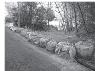
▲道路沿いの土のう
