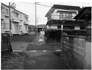
▲中溝地区の町道局部改良
