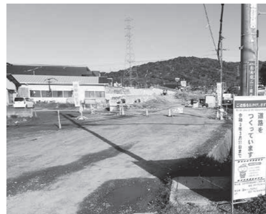
▲ 県道矢野安浦線道路改良工事
