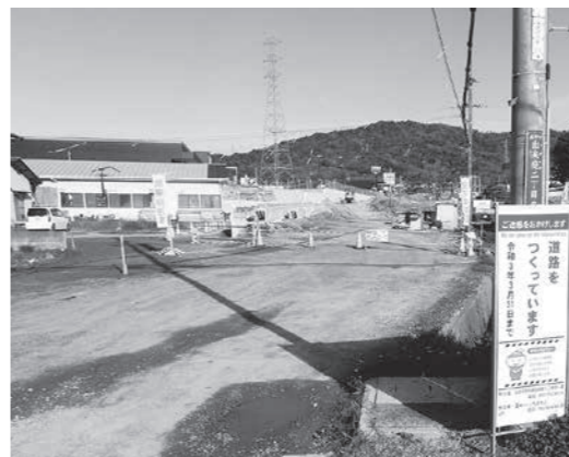
▲ 県道矢野安浦線道路改良工事
