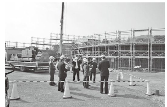
▲ 令和3年3月完成予定の(仮称)東部地域防災センター
