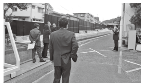
▲ 「熊野第三小学校擁壁改修工事」が完了した現場
