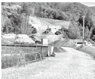
▲ 工事中の深原バイパス
