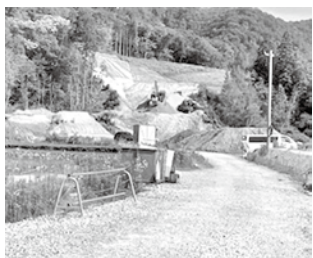
▲ 工事中の深原バイパス
