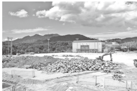
▲ 改修前（町民グラウンド）
