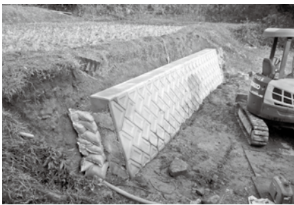
実際に復旧された被災箇所
