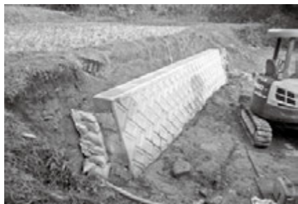
実際に復旧された被災 箇所
