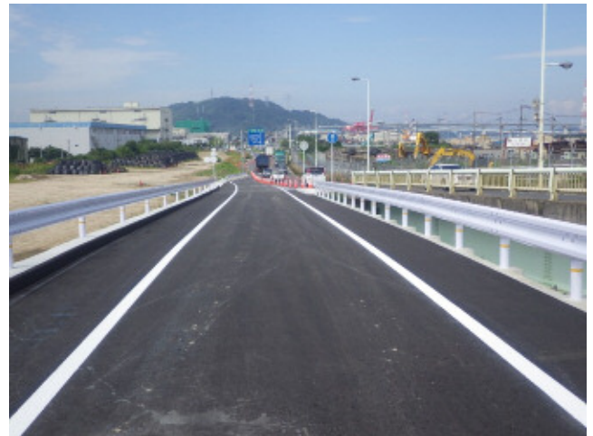
写真-2 起点側完成状況
