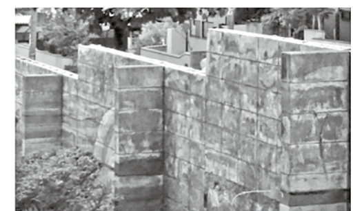
▲「ブロック塀改修工事現場」を視察
