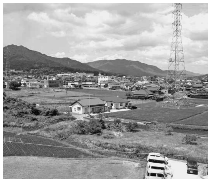
▲県道延伸予定地
