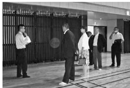
◀ 体育館内壁に設置された輻射式空調設備
