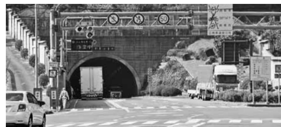
▲ 広熊トンネル入口
