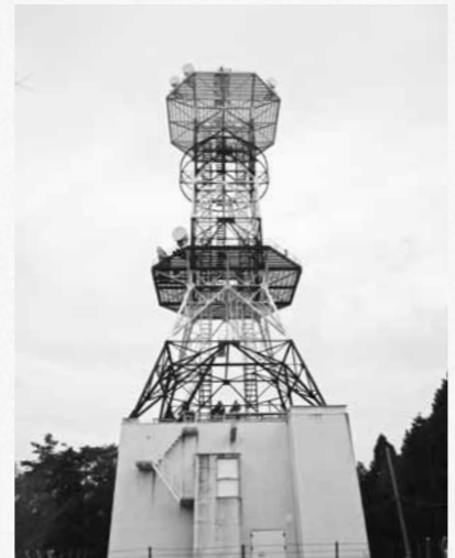
▲ 頂上付近の電波塔
