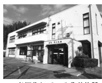
▲ 老朽化している公共施設
