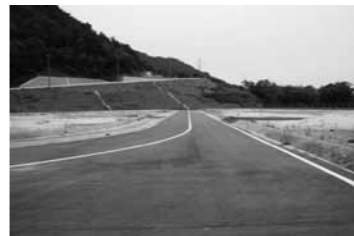
▲売却に向け工事が行われる町道
